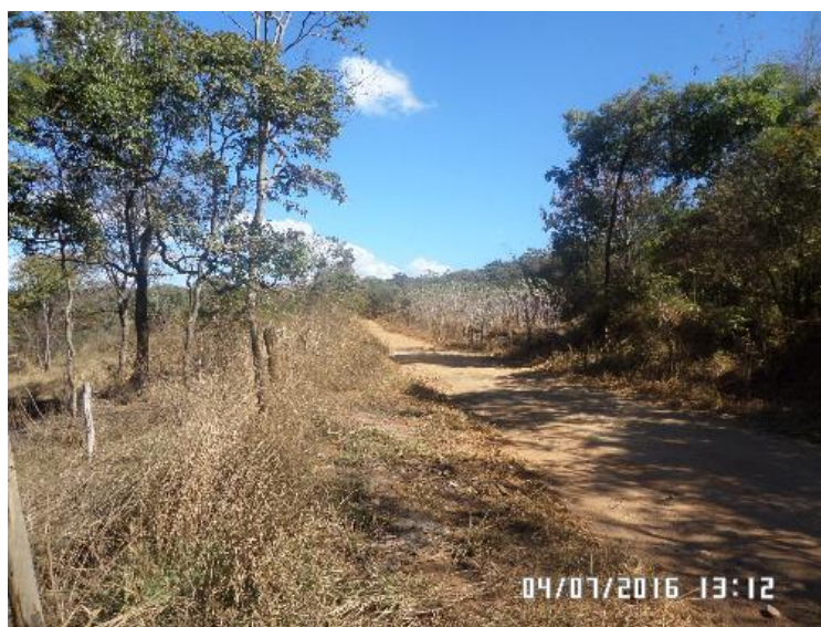
Figura 6.2 - Estrada vicinal à montante da Lagoa do Fluminense
